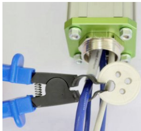
Die Spreizzange ist hilfreich zum Einführen von Kabeln in den Dichteinsatz
