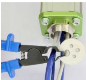
Die Spreizzange hilft beim Einführen von Kabeln in den Dichteinsatz
